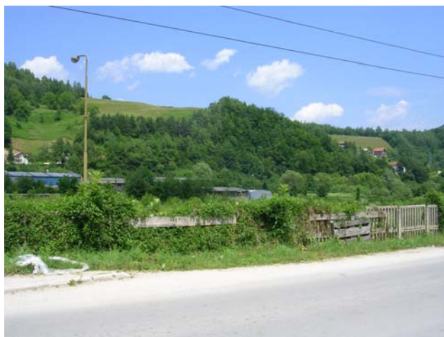
Slika 12. Završetak trase na portalu buduće TS 110/x Fojnica
